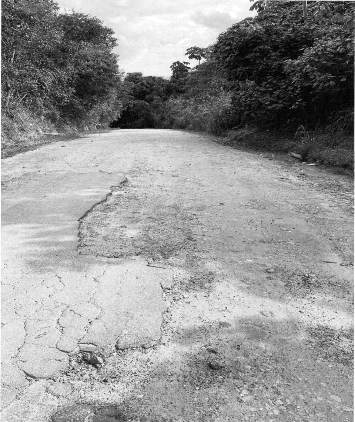
NIVELAMENTO E APLICAÇÃO DE FRESA DE ASFALTO EM TODA A EXTENSÃO DA RUA RIKIO SUENAGA, JD. EUROPA – MOGI DAS CRUZES.
